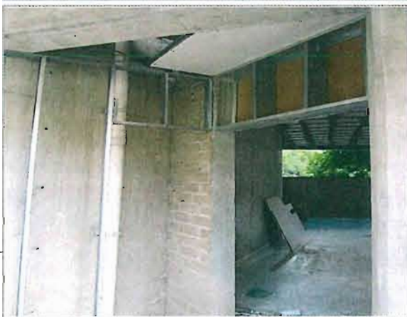
F3: Trabajos de recubrimientos y acabados durok
