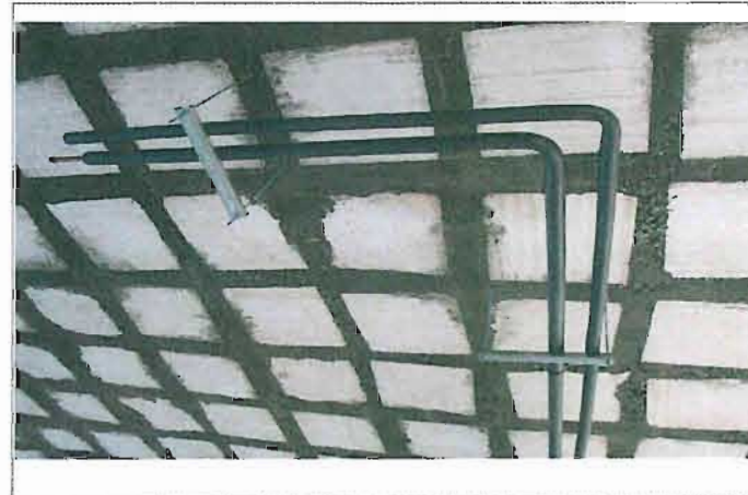
F2: Preparación de instalaciones equipos de A/A
