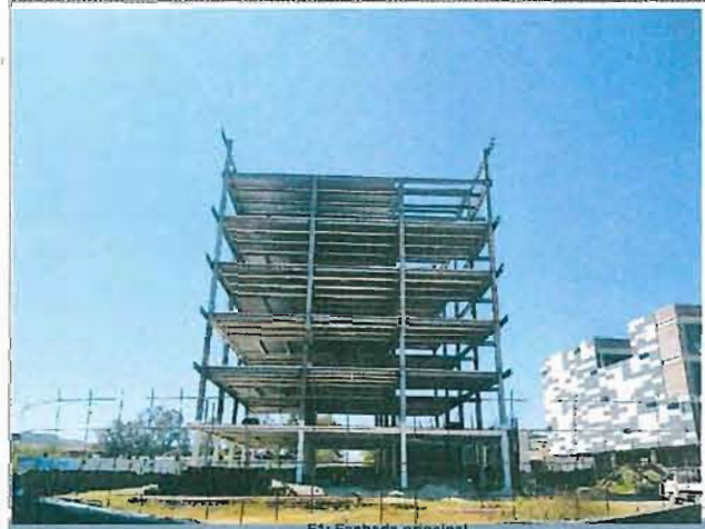
F1: Fachada principal
