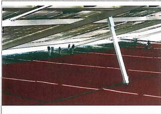
F1: Impermeabilización en azotes
